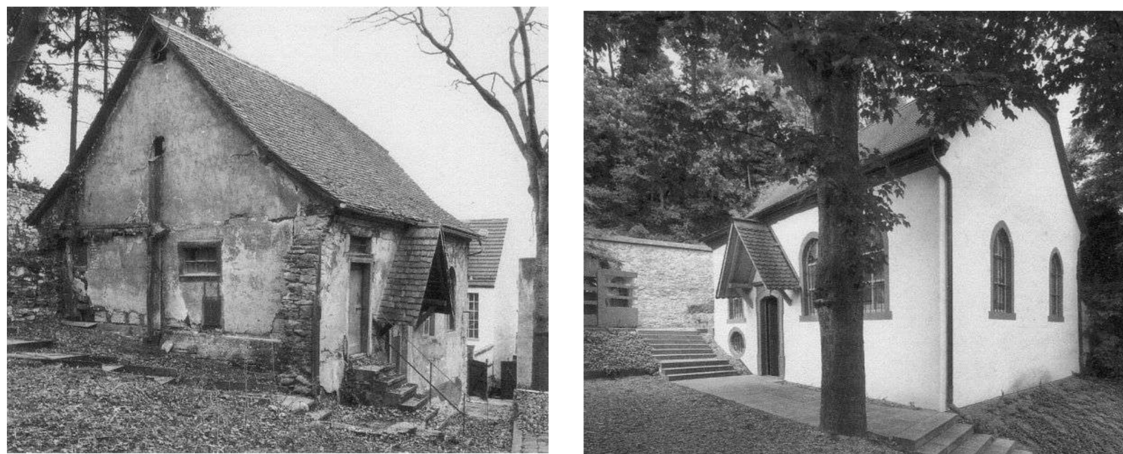
Figura 12 e 13. A Sinagoga de Wiesenau, antes e depois das obras de restauro dos anos 90 (Fonte: http://www.alemannia-judaica.de )
